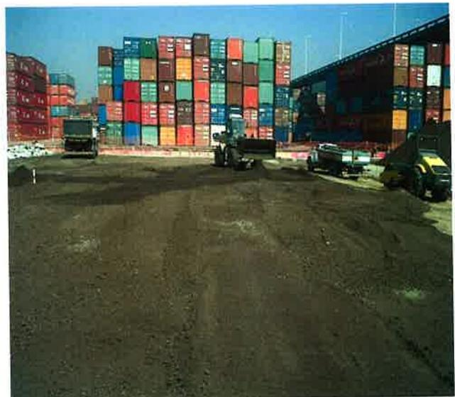
BRITAGEM COM PENEIRAMENTO CLASSIFICATÓRIO DE 3000 M3 DE MATERIAL RECICLADO PARA APLICAÇÃO EM BASE E SUB-BASE NO PORTO DO RIO DE JANEIRO.
